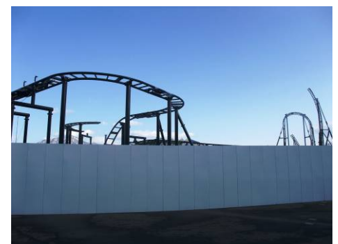
↑新コースターの仮囲い
