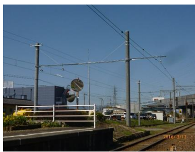
(江尾構内電柱の PC 化工事)
