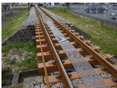
(中里橋梁の合成まくら木化工事)
