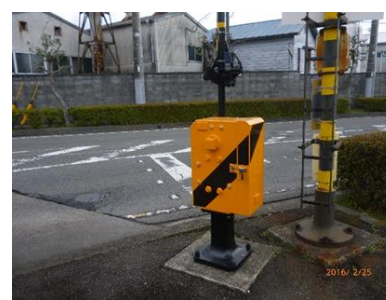
(田宿踏切遮断機更新工事)
