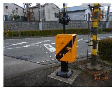
(田宿踏切遮断機更新工事)
