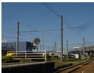
(江尾構内電柱の PC 化工事)
