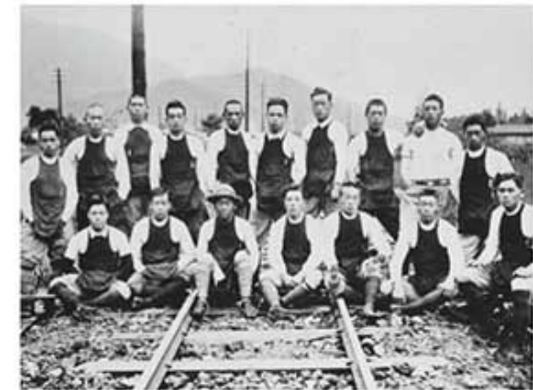
線路敷設工事の様子
