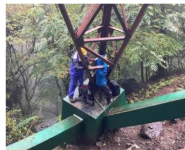
構造の安全性を確認する身延登山鉄道での支柱健全度調査
